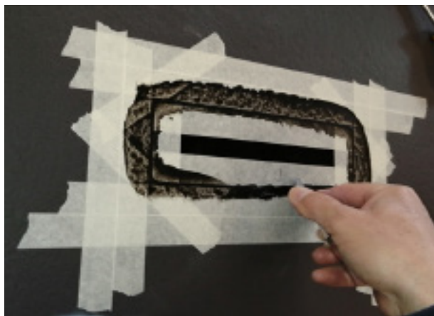
Fig.10 - Come proteggere il piano dalla fase di siliconatura e successiva pulitura/uniformità del silicone
